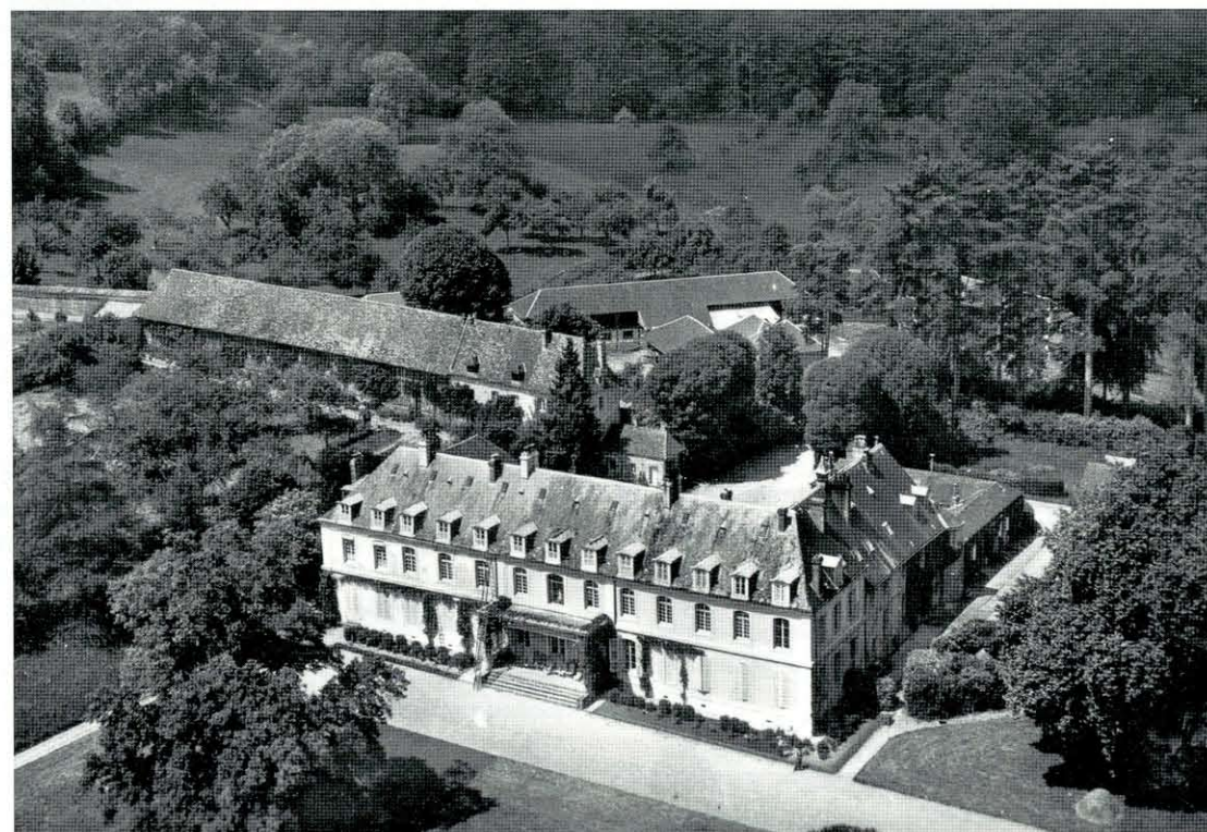
Ce qui subsiste des bâtiments conventuels... (remaniés, sans doute !) vers la gauche, la ferme, les écuries... Coll. Val-Richer
